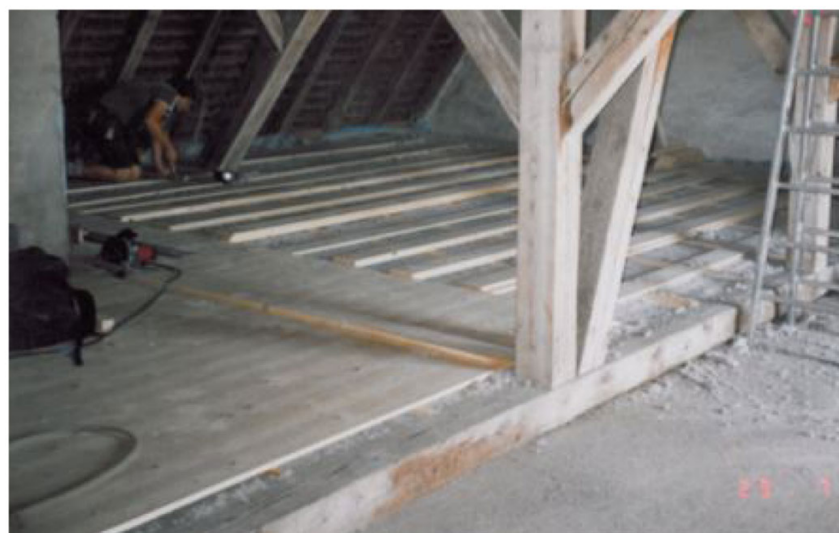
Der neue Riemenboden überdeckt den störenden Überzug
