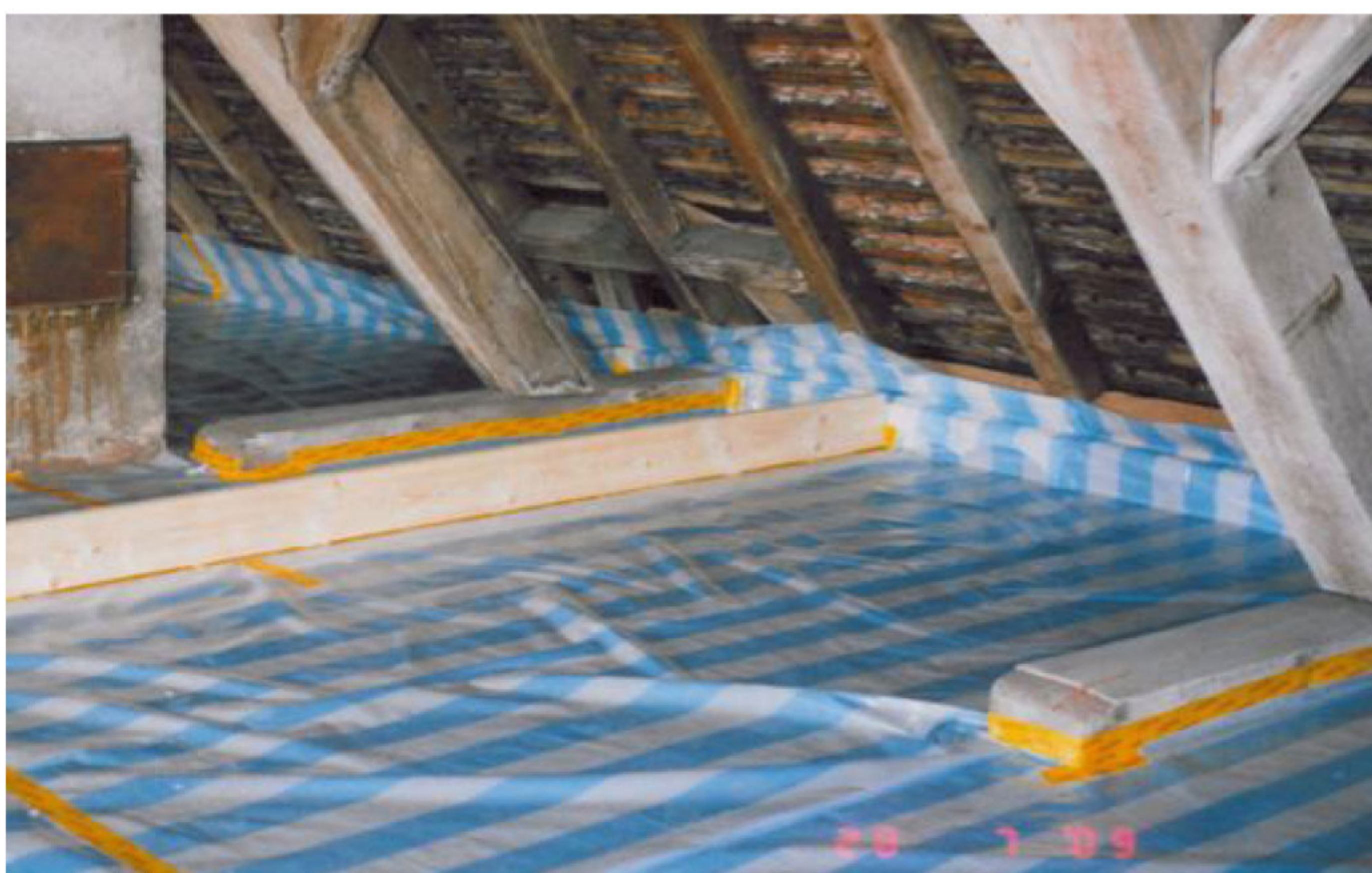
Auslegen der Dampfsperr-Folie, Stöße verklebt
