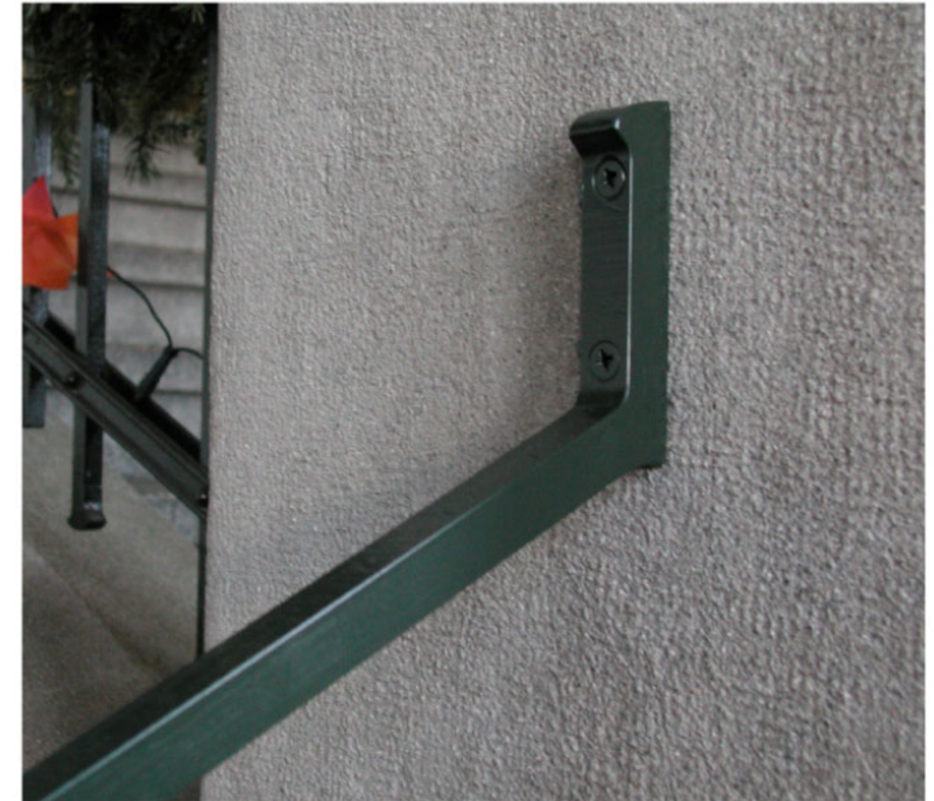
Ergänzung bzw. Erhöhung des Geländers mittels Laserstrahl ausgeschnittenen 2cm dicken Eisenblechen
