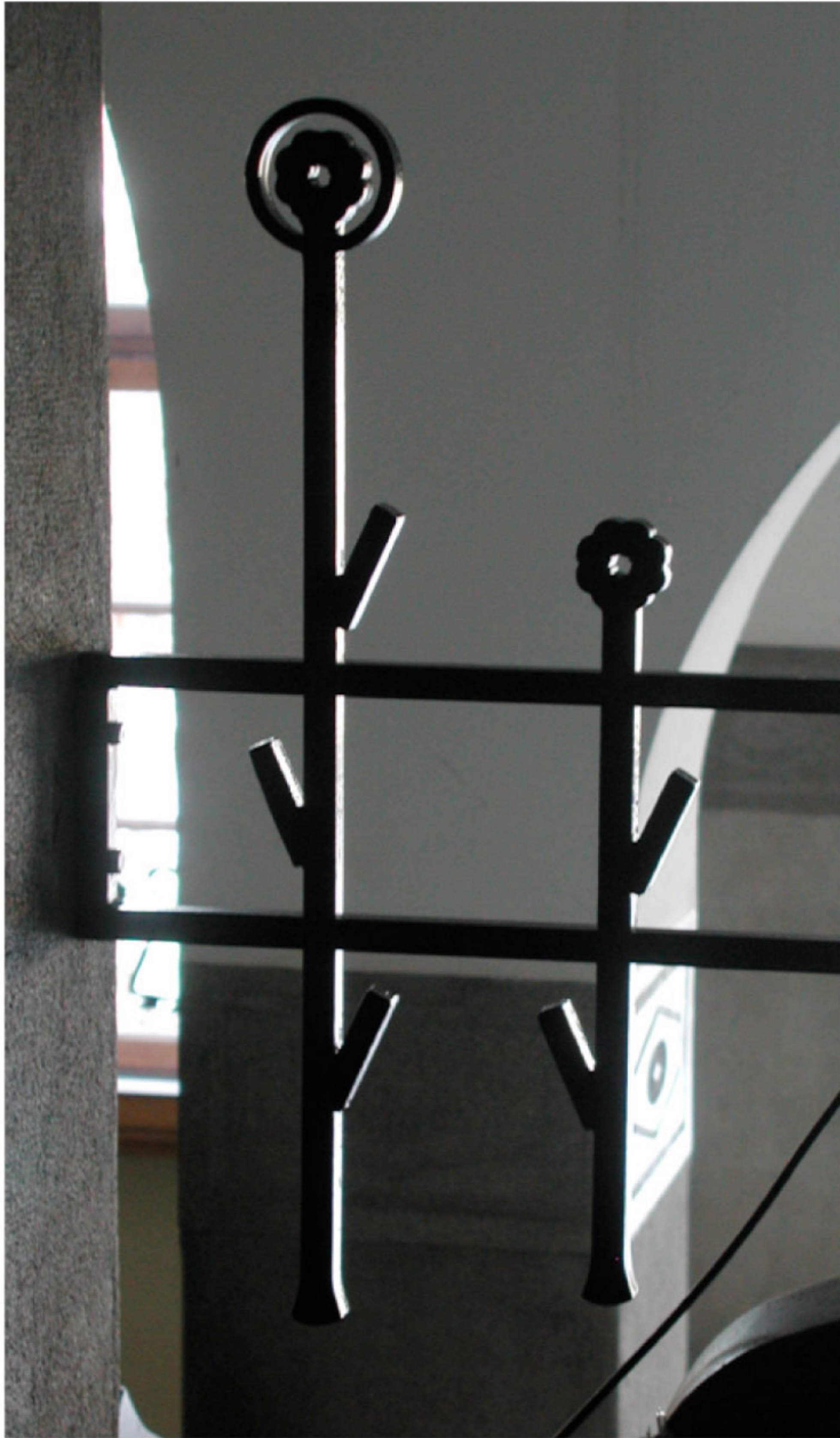
Ergänzung bzw. Erhöhung des Geländers mittels Laserstrahl ausgeschnittenen 2cm dicken Eisenblechen
