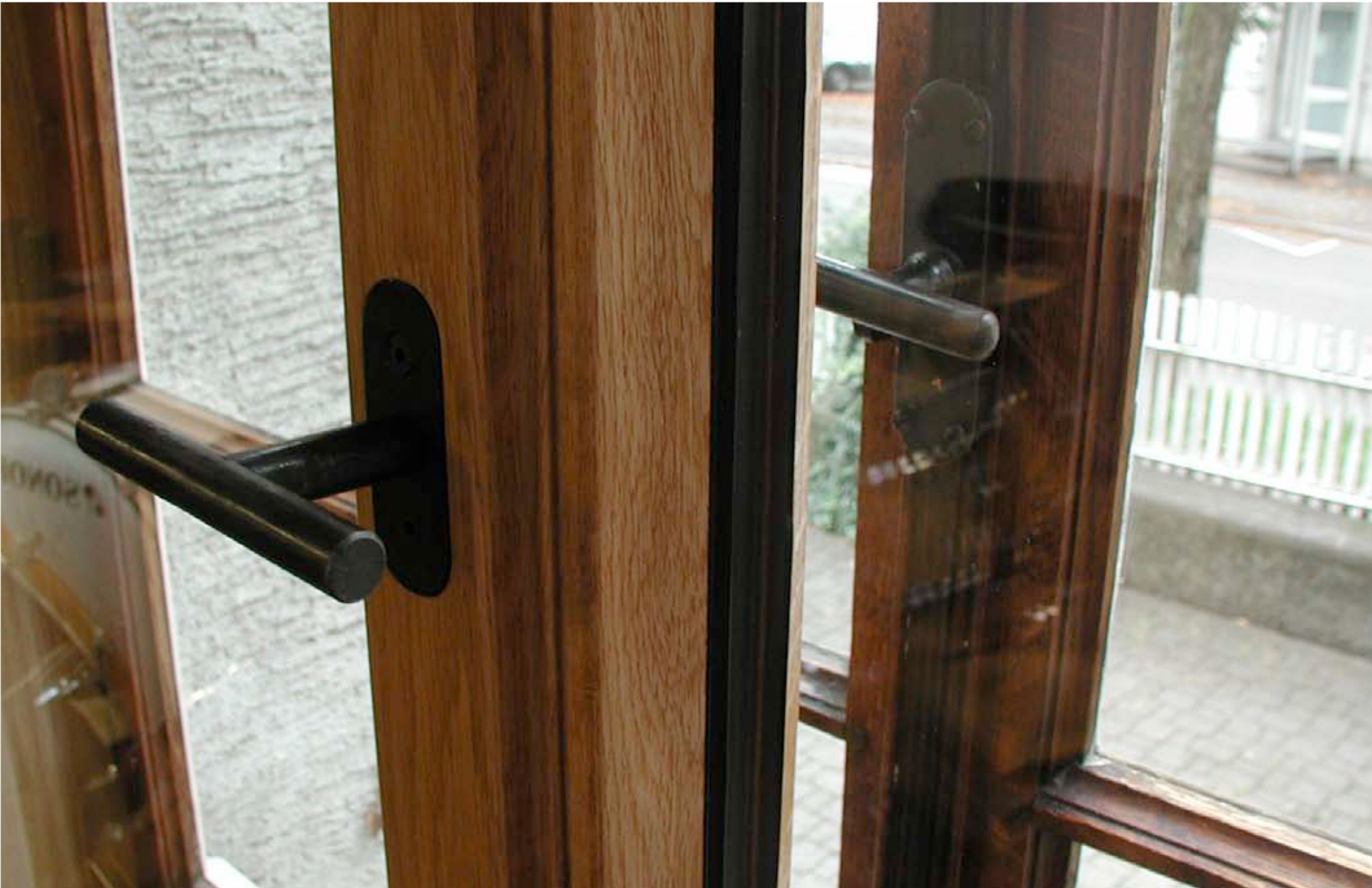
die neuen Fensteroliven korrespondieren mit den alten in Form und Material
