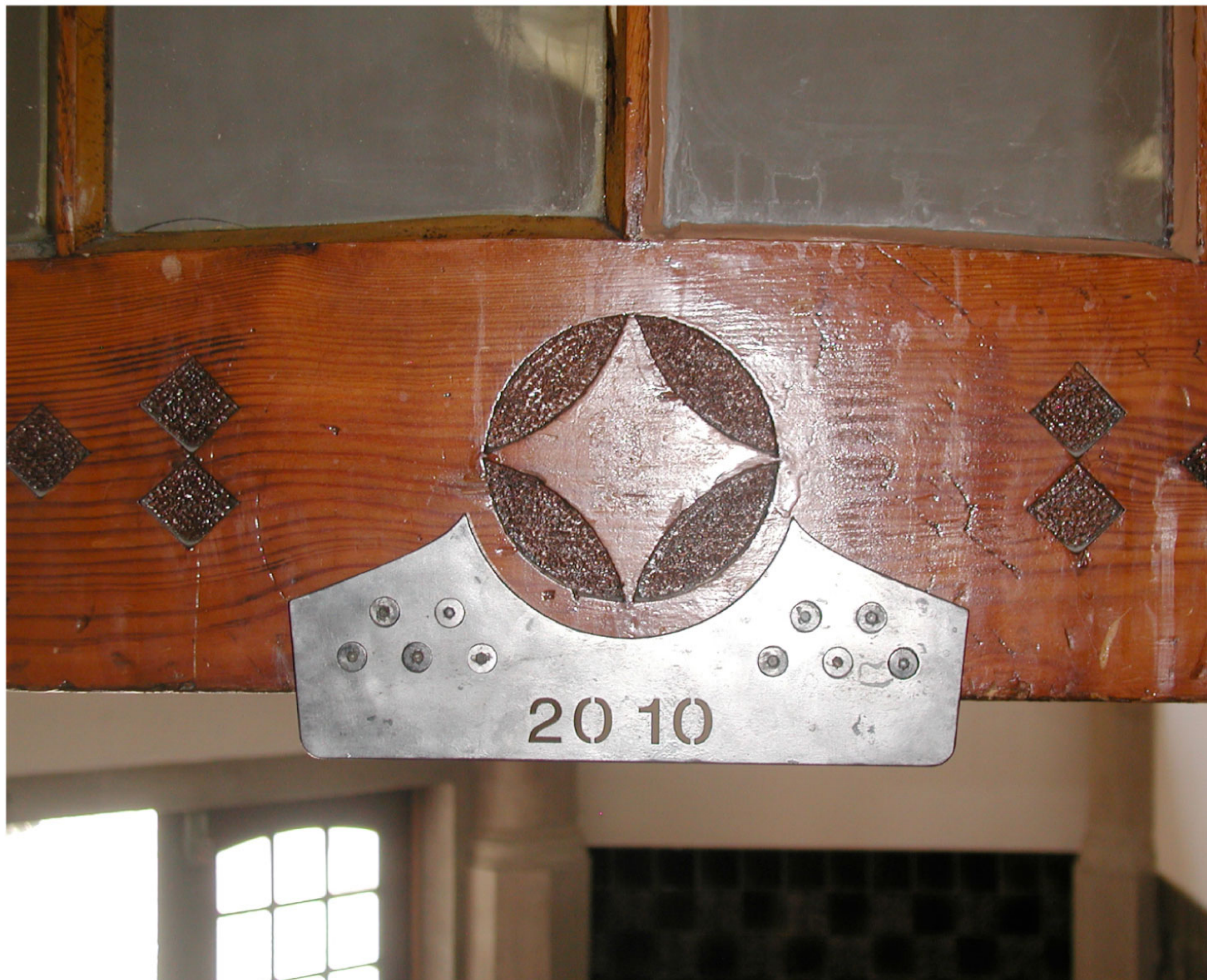
neuer Türanschlag - die bestehenden Schwingtüren bildeten ein Sicherheitsrisiko
