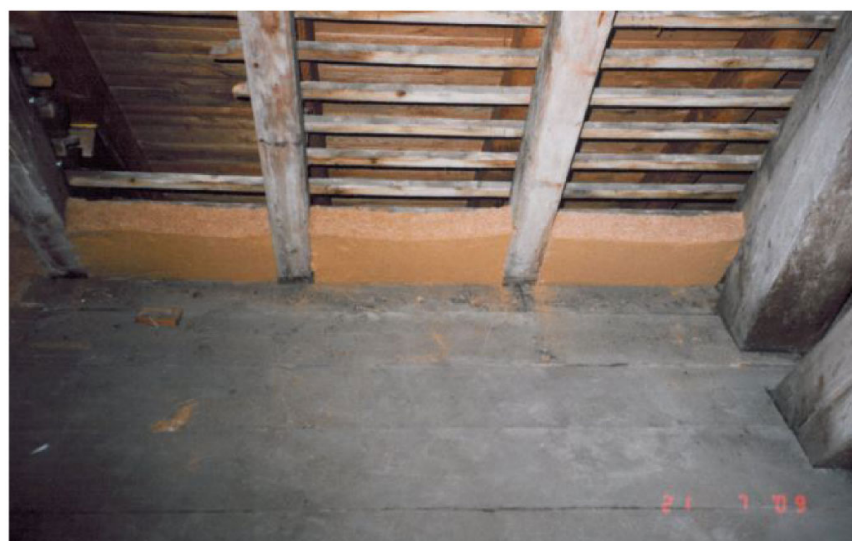
der Sparrenzwischenraum mit "steifer" Dämmung gedämmt
