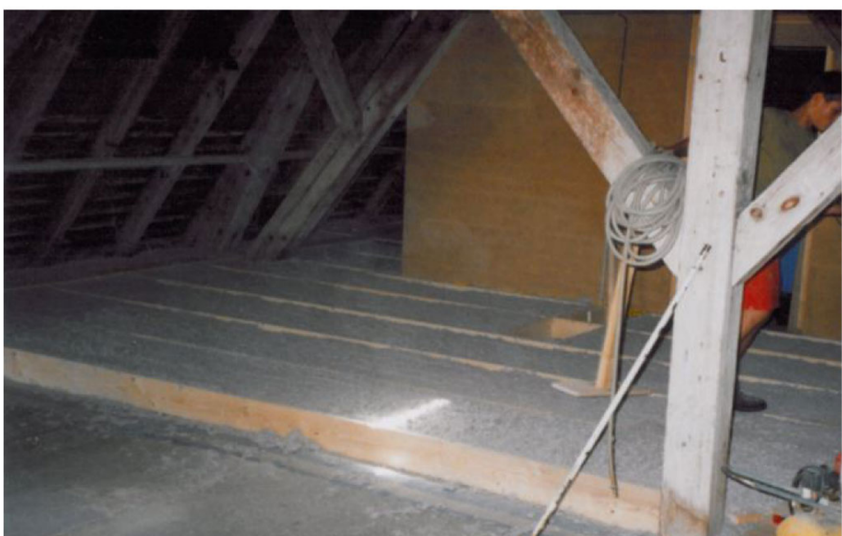
Ausflocken der Dielengefache mit Zellulosedämmung
